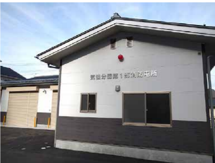
最後に復旧した一部屯所。旧屯所の教訓から車庫隣に車庫と同じ広さの倉庫を設けた。休憩室も以前より広くし、利便性、機能性を向上させた。
